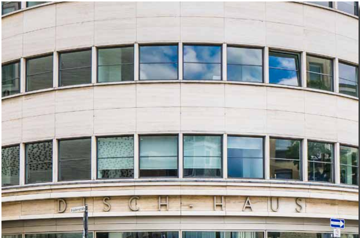
Detailansicht des Disch-Hauses in Köln
